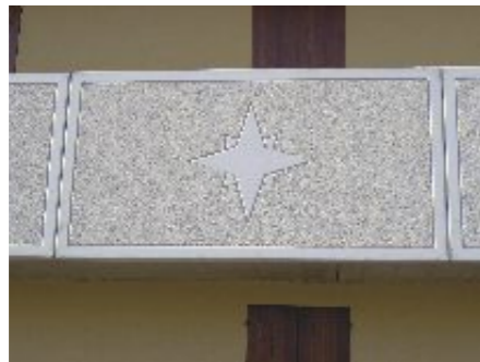
Parapetti colorati e bocciardati Mantova >
