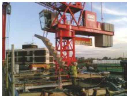
Complesso residenziale/commerciale Londra (UK) >
